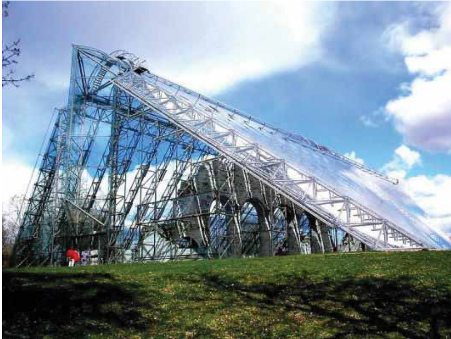
Figur 41: "Hamardomen", Ruiner etter gamle domkyrkja på Hamar blei pakka inn i vêrbeskyttande glaskonstruksjon i 1998. Foto: Torstein Frogner (wikipedia.no 2010)
