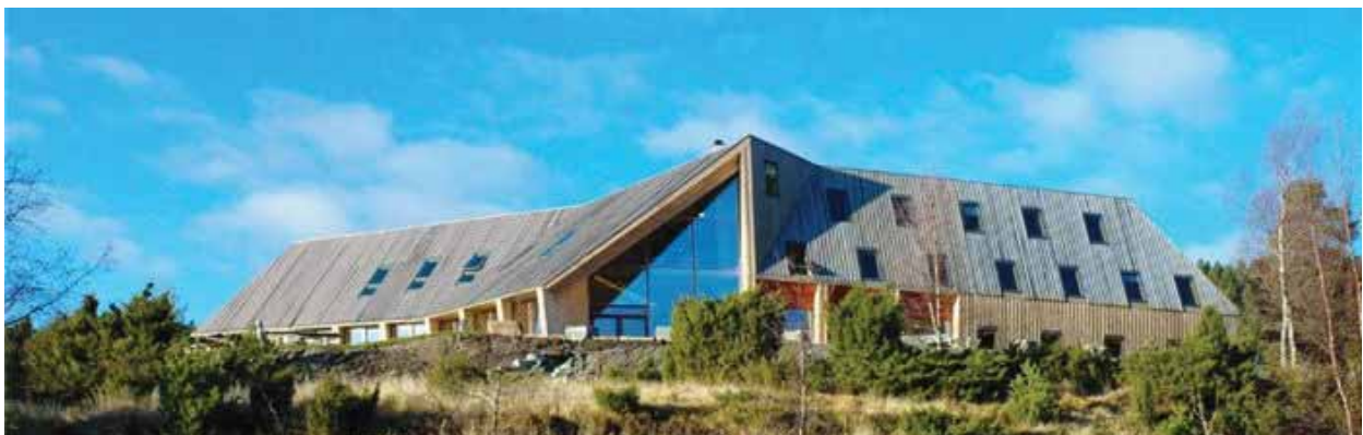
Figur 47: Preikestolen fjellstove ligg forma etter terrenget med sørvendte glasflater. Med si kompakte og isolerte bygningsform og tette klimaskjerm ligg stova i energiklasse A. Fjellstova fekk statens byggeskikkpris i 2009 (NAL ecobox 2010: Norwegian Wood - Preikestolen fjellstue www.arkitektur.no )
