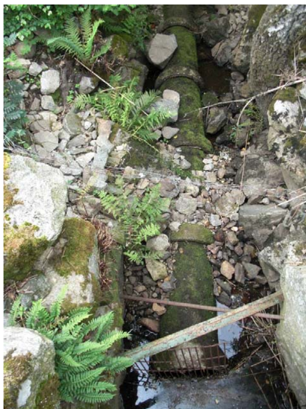
Figur 10. Øverste vandringshinder, rør som ligger i dagen
