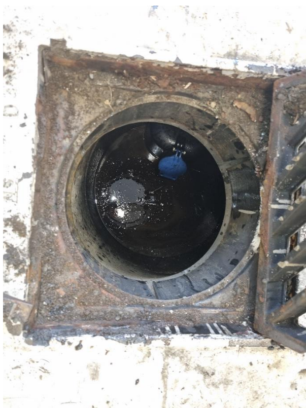
Rist i verkstedhall.
