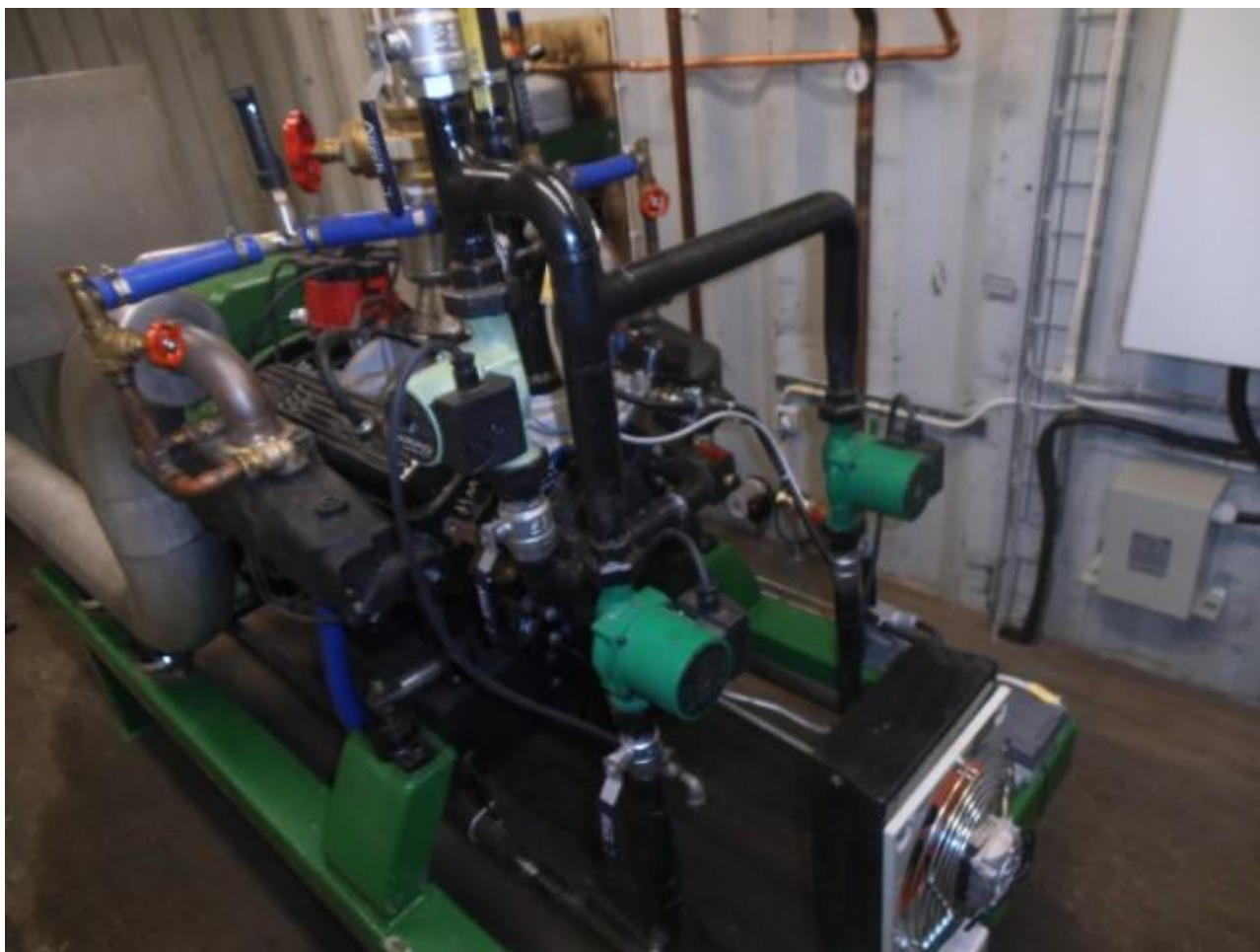
Figur 5: Gassmotor for å produsere strøm fra biogass.
