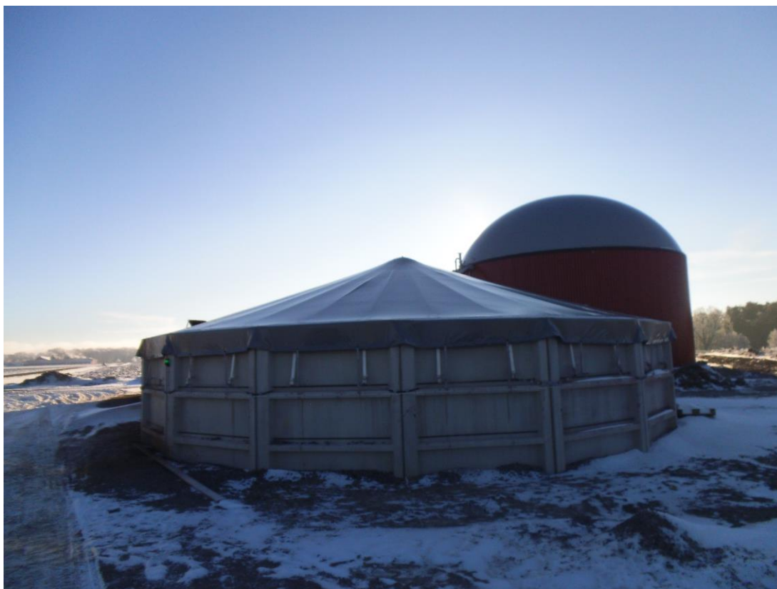
Figur 3: lagertank for biogjødsel.
