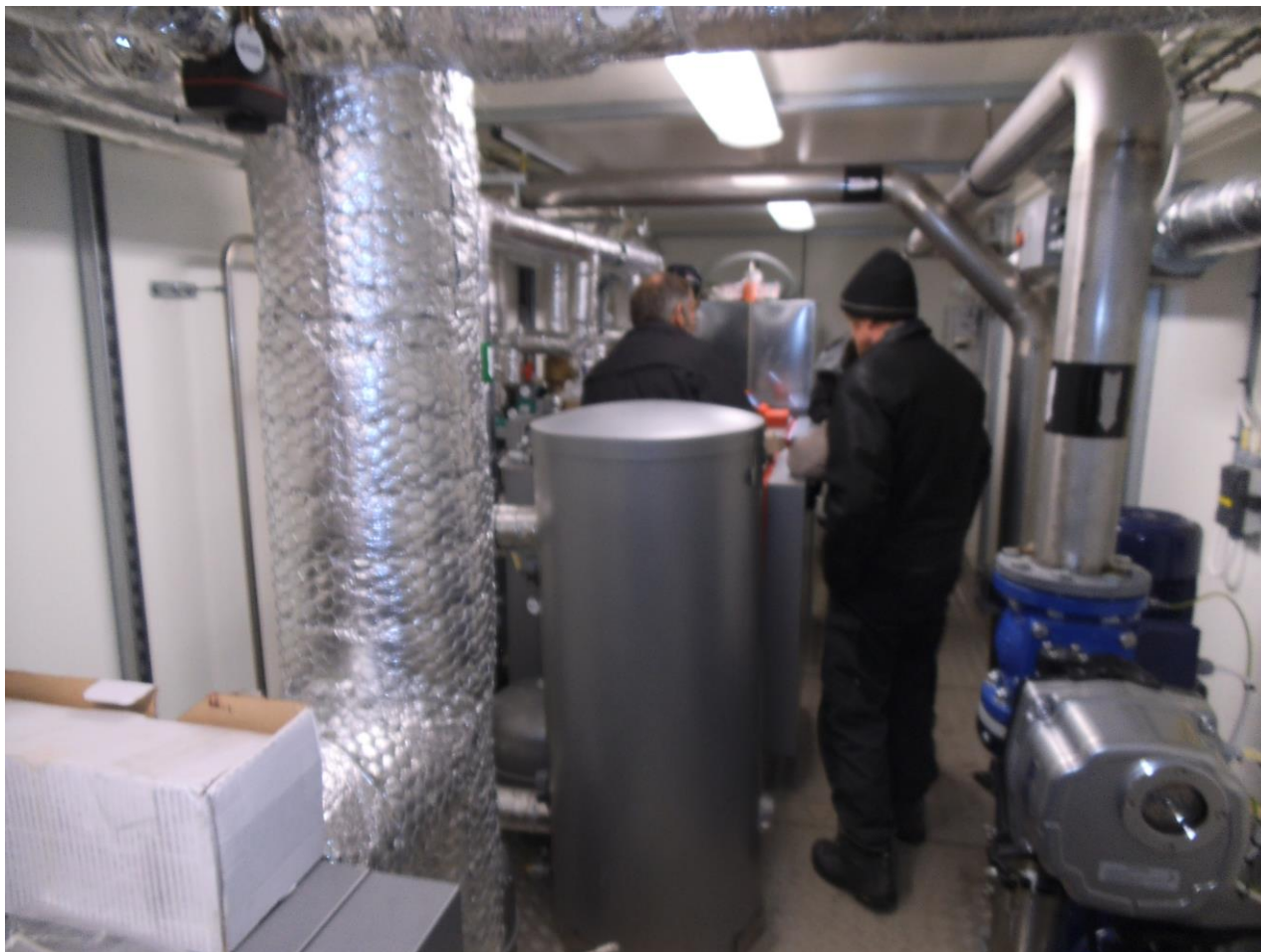
Figur 2: System for rensing av biogass. Systemet kommer ferdig i containerløsning.
