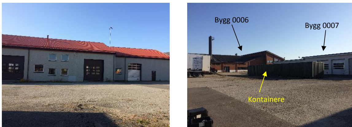
Figur 5.5: Bildet til venstre viser bygg 0008 med verksted (bildet er tatt mot øst). Bildet til høyre viser bygg 0006 med fyrrom) og bygg 0007 med verksted (bildet er tatt mot sørøst). Foto: Multiconsult.
