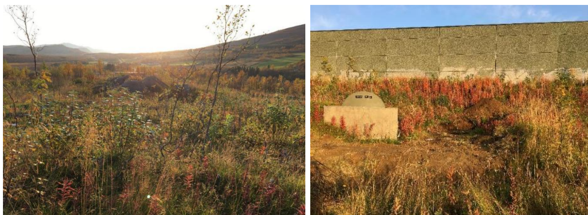
Figur 5.2: Bilde fra vestre område i leiren. Bildet til venstre viser området der det er plassert hauger med masser/betongrester, bildet er tatt i sørvestlig retning. Bildet til høyre viser tanken plassert i betongkum med bygg 0064 i bakgrunnen, bildet er tatt mot øst. Foto: Multiconsult.
