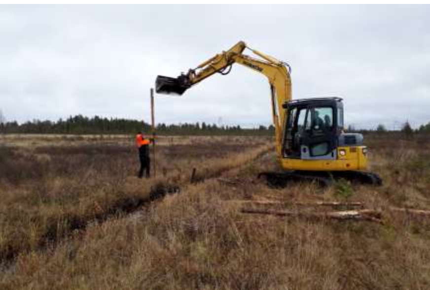
Filling of a ditch in a moor Photo: Länsstyrelsen Västerbotten
