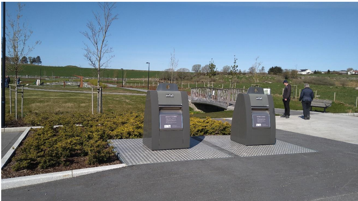
Nedgravde avfallsdunkar på Time gravplass i Time kommune. Her ble det planlagt for nedgravde avfallsdunkar i forbindelse med utvidinga. Foto: Statsforvalteren i Vestfold og Telemark.
