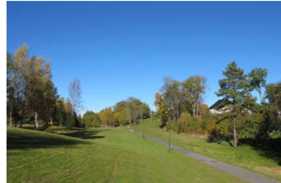
Foto: Roger Jensen Lundedalen. Godt fungerende gang- og sykkelveg med asfaltdekke og belysning. Oppfyller krav til universell utforming.
