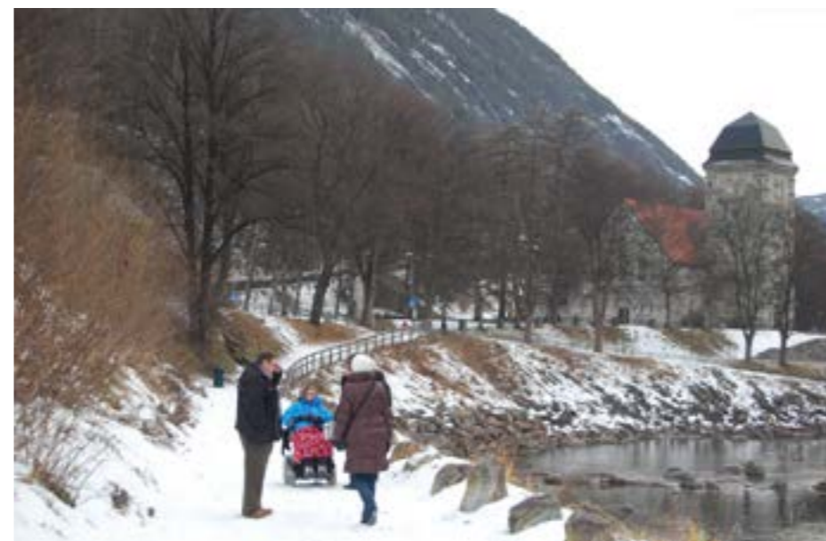
Foto: Ingvild Johnsen Jokstad Månastien med Rjukan kyrkje i bakgrunn. Stigningen i bakken er ikke i henhold til universell utforming (her 1:1), men fungerer brukbart for rullestolbrukere med assistent. Rekkverket burde hatt håndlist. Langs stien står det stabbesteiner mot elva som sammen med en "voll" danner lederlinje.
