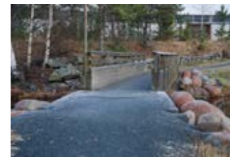
Foto: Bjørg Wethal Bru over Eidsborgbekken. Litt ujent dekke og behov for utbedring av overgang turveg - bru.
