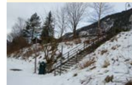
Foto: Ingvild Johnsen Jokstad Tverrforbindelse mot Månaveien. Pga stor høydeforskjell er det vanskelig å etablere gode ramper på langs av terrenget.
