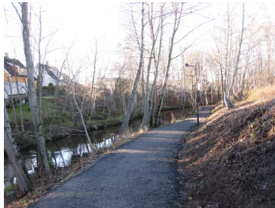
Foto: Elin Katrine Nilssen Del av turveg som er oppgradert i 2012 med vegetasjonsrydding, grøfting, ny grus og belysning.
