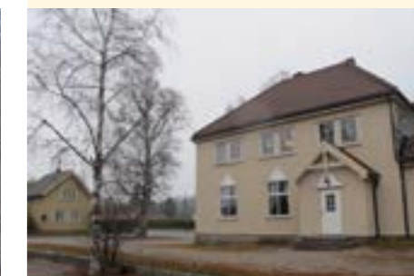
Foto: Roger Jensen Den gamle stasjonsbygningen.
