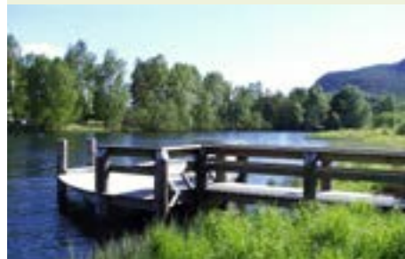
Foto: Øyvind Dahle Badebrygge. Etablering av en rampe i overgangen treverk/terreng ville gitt rullestolbrukere tilgang til brygga som kunne vært brukt som fiskeplass/hvileplass. Det finnes en badeplass lengre vest som har større potensial for tilrettelegging.
