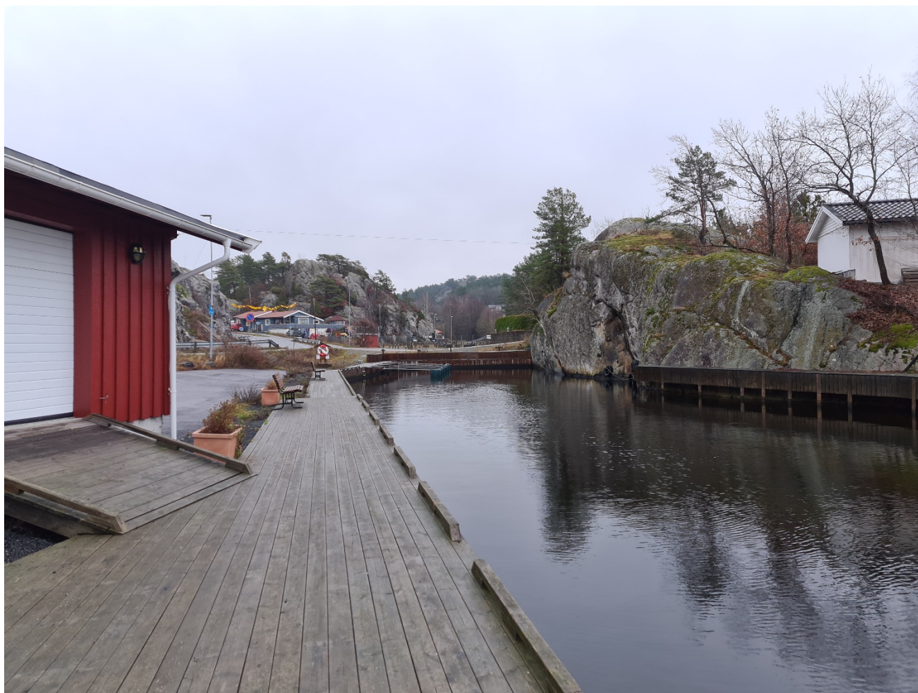
Figur 1. Bildet tatt fra vest mot øst. Eiendomsgrensen i øst går omtrent der badebøyen er plassert. Bekken som kommer østfra renner ut lengst inne i bukta, til venstre, bak utstikkerne som kan sees på bildet.
