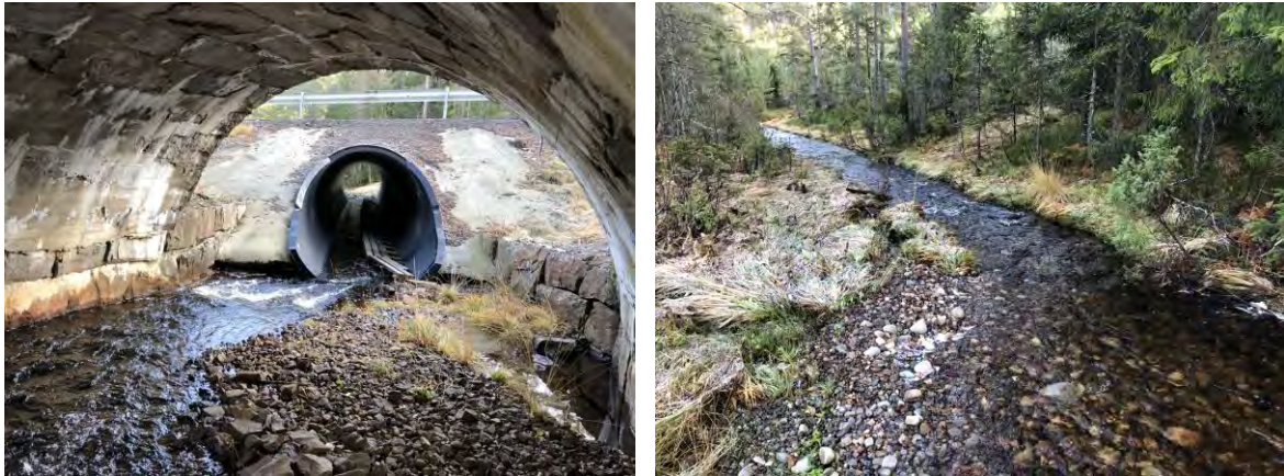
Figur 5-15: Jerpeljønnsbekken krysses av både Sørlandsbanen og dagens E134
