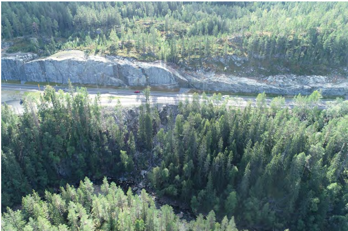
Figur 5-4: Ny E134 like vest for Vollåstunnelen. Det har havnet sprengstein og betongrester i skråningen ned mot Kobberbergselva. Dronebilde tatt august 2020 av ScanSurvey
