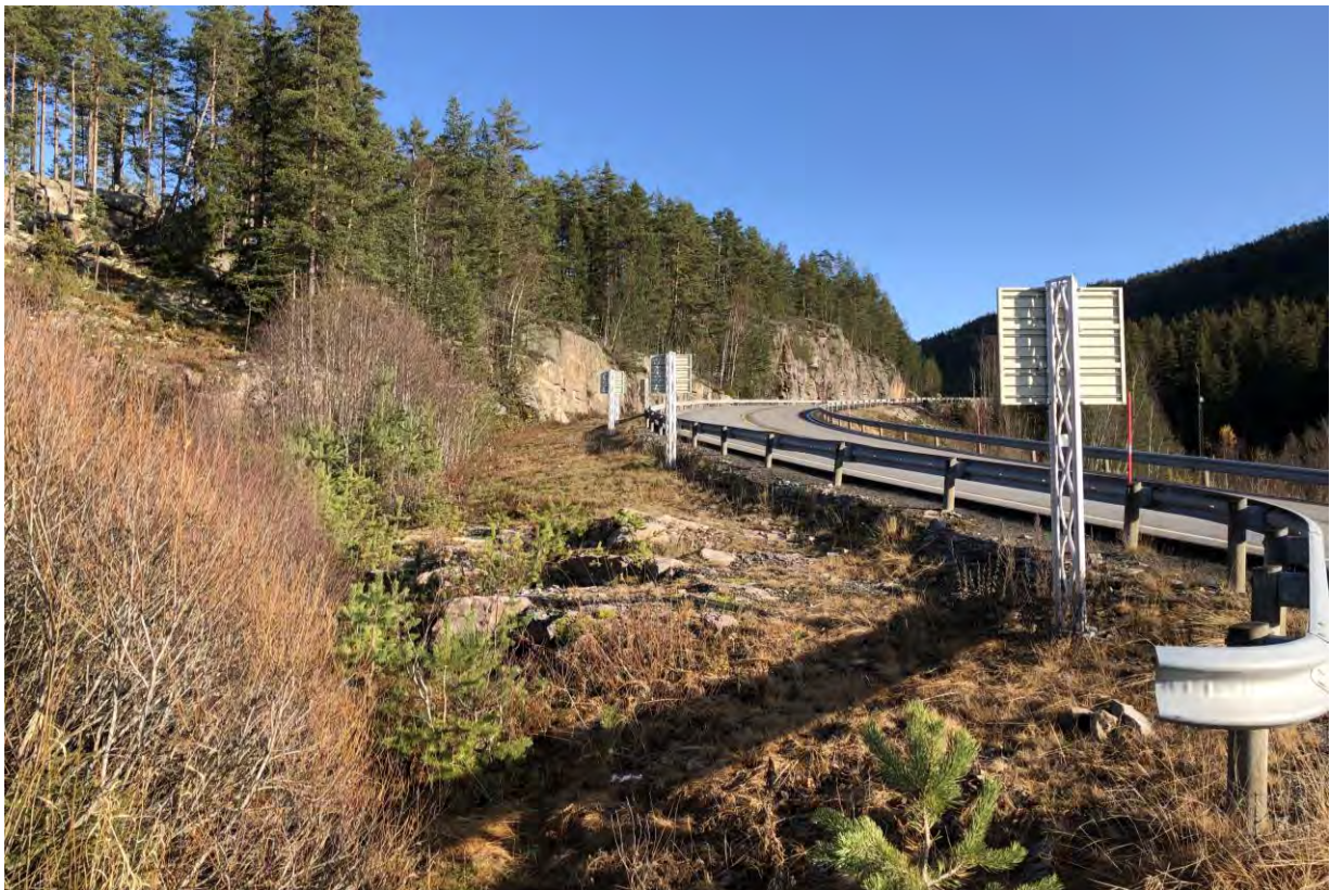
Figur 1-2: Dagens E134 har store stigninger og krappe svinger
