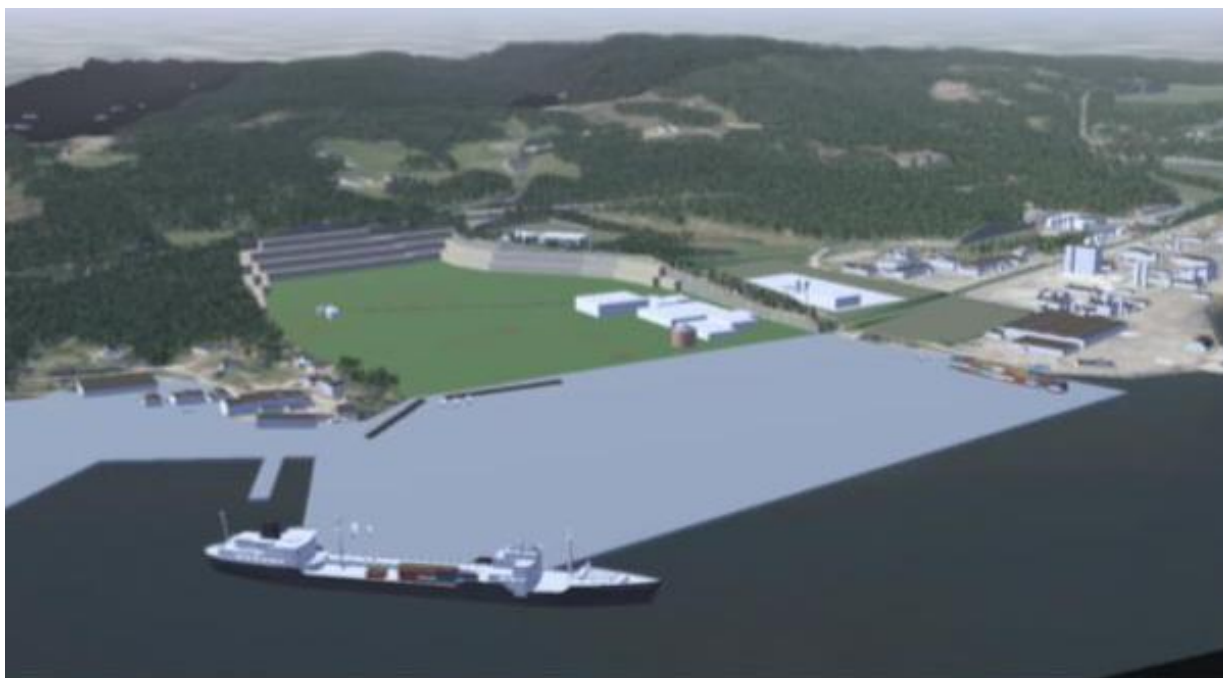
Figur 2. 3D -modell som viser utfylling av havneområde i samsvar med forslag til områderegulering, hentet fra figur 6-15 i planbeskrivelsen for Frier Vest.
