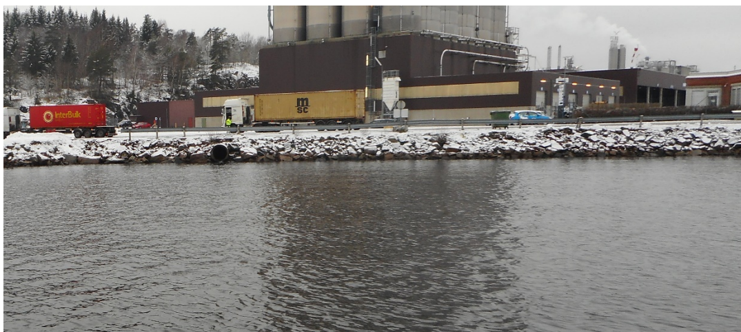
Figur 5: Utløp/kulvert av ukjent opphav fra industriområdet ved Asdaltangen. Bildet tatt ca. fra sedimentstasjon 7.
