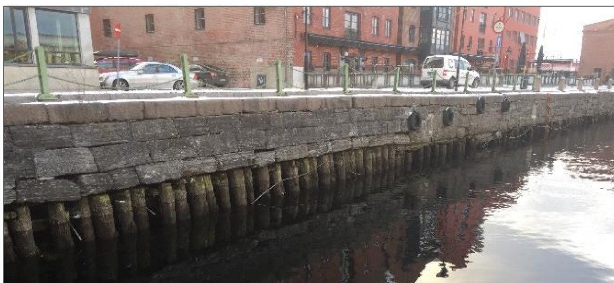
Figur 2. Bilde av dagens kaifront på Langbrygga. Kaifronten skal reetableres i eksisterende naturstein.
