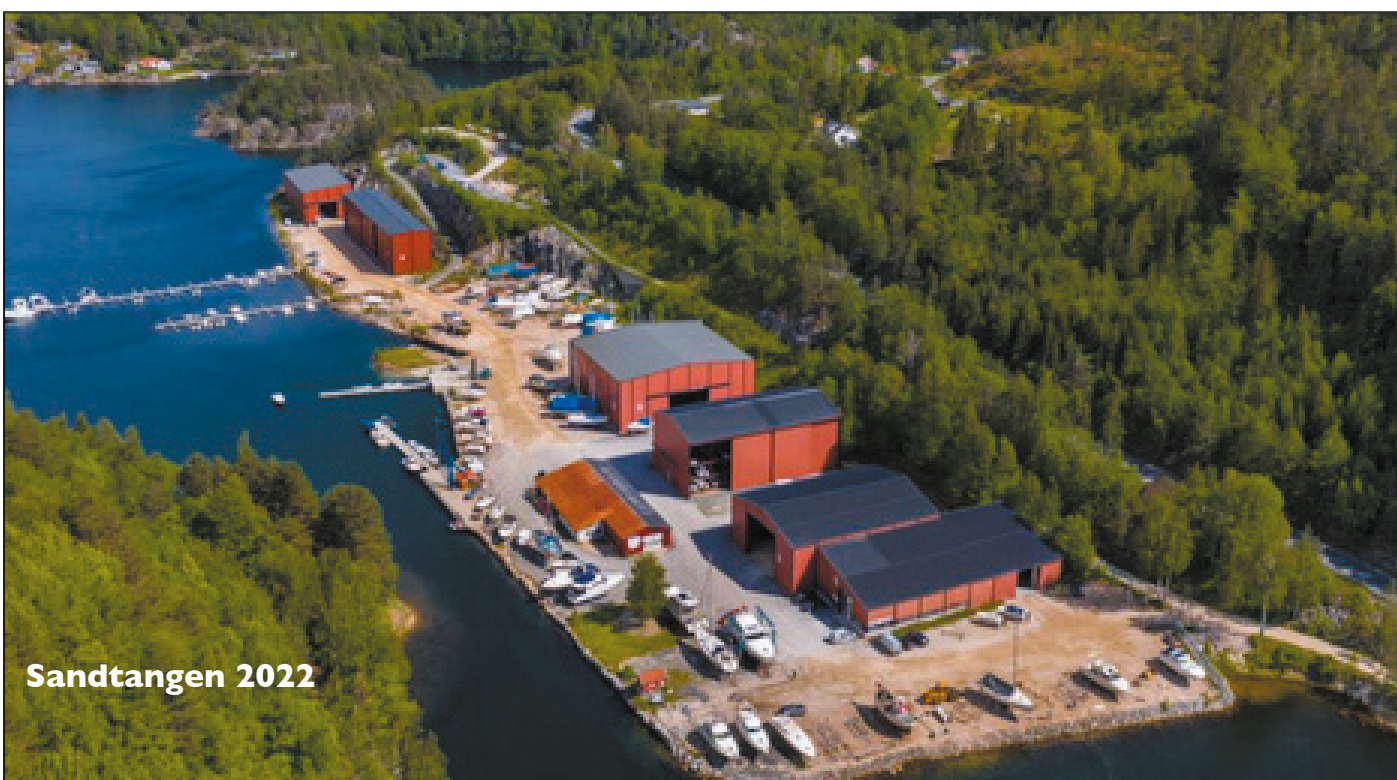
Sandtangen etter utsprenghing og utfylling til utvidelse av båthavnen, samt flere opplagshaller
