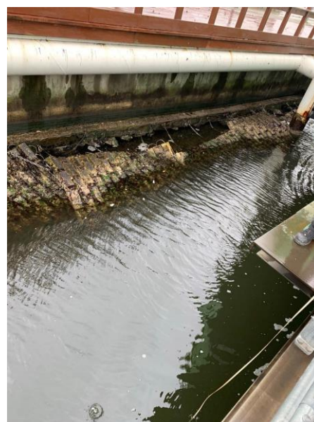
Figur 3: Betongmadrasser hengende ut fra eksisterende kai.
