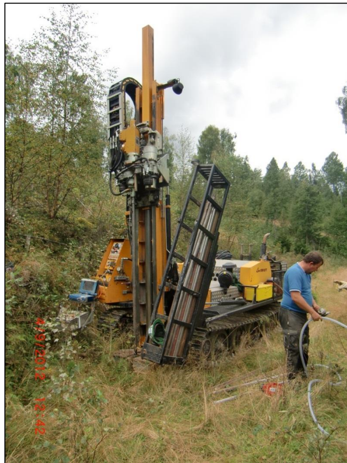
Bilde 7: Lett boremaskin for sonderboring og nedsetting av peilerør.
