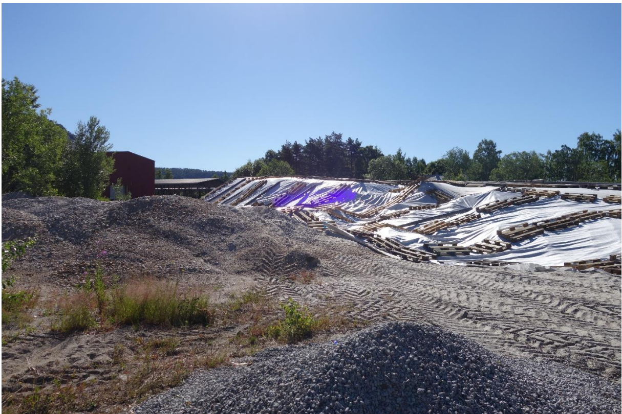
Figur 5. Det er henta opp grus frå ein del av planområdet ute i Nisser og lagra på land. Masane er dekt med presenningar for å hindre sandflukt.
