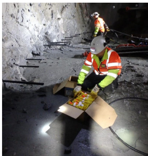
Foringsrør i borehull. Foto: Statens vegvesen
