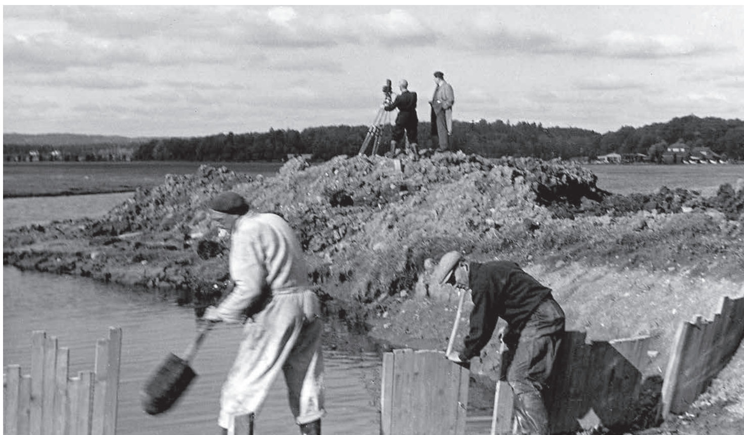
Grøftene ble i stor grad gravd ut med håndmakt. Det sies at to mann gravde over 80 meter dreneringsgrøft per dag! ▲
