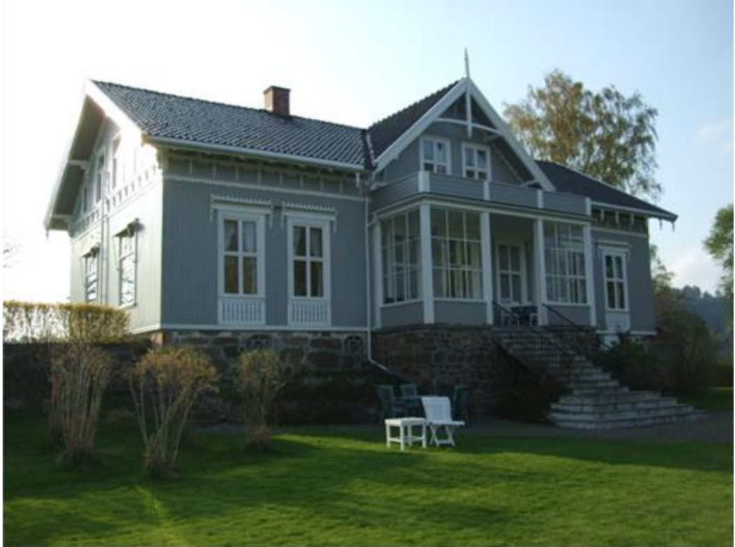
Hovedbygningen er et blikkfang i landskapet, og har stor bevaringsverdi. Foto: Morten W. Melby.
