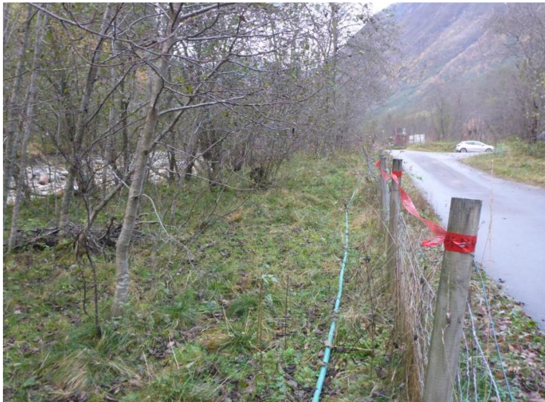
Figur 2-15 Typisk terreng for rørgate på Fosseteigen kraftverk
