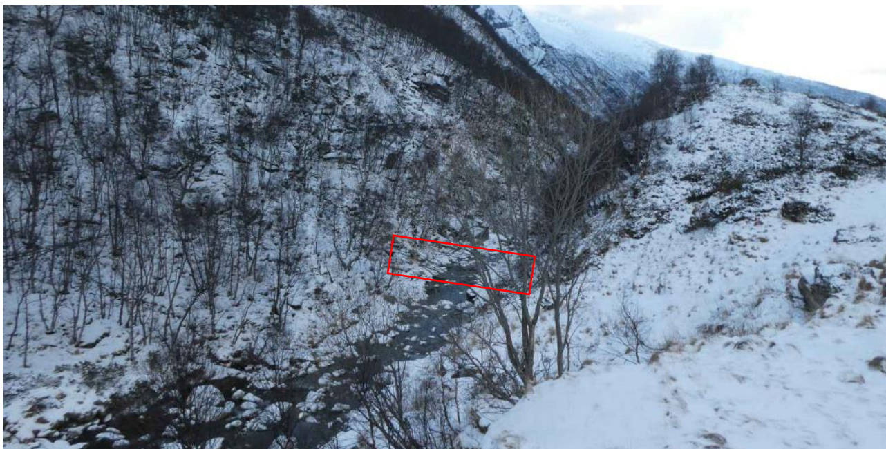
Figur 2-1: Oversiktsbilde over inntaksområdet sett medstrøms. Område for dam er vist med rødt. Grop for sjakt er planlagt avgravid/utsprengt på venstre side av elveløp.
