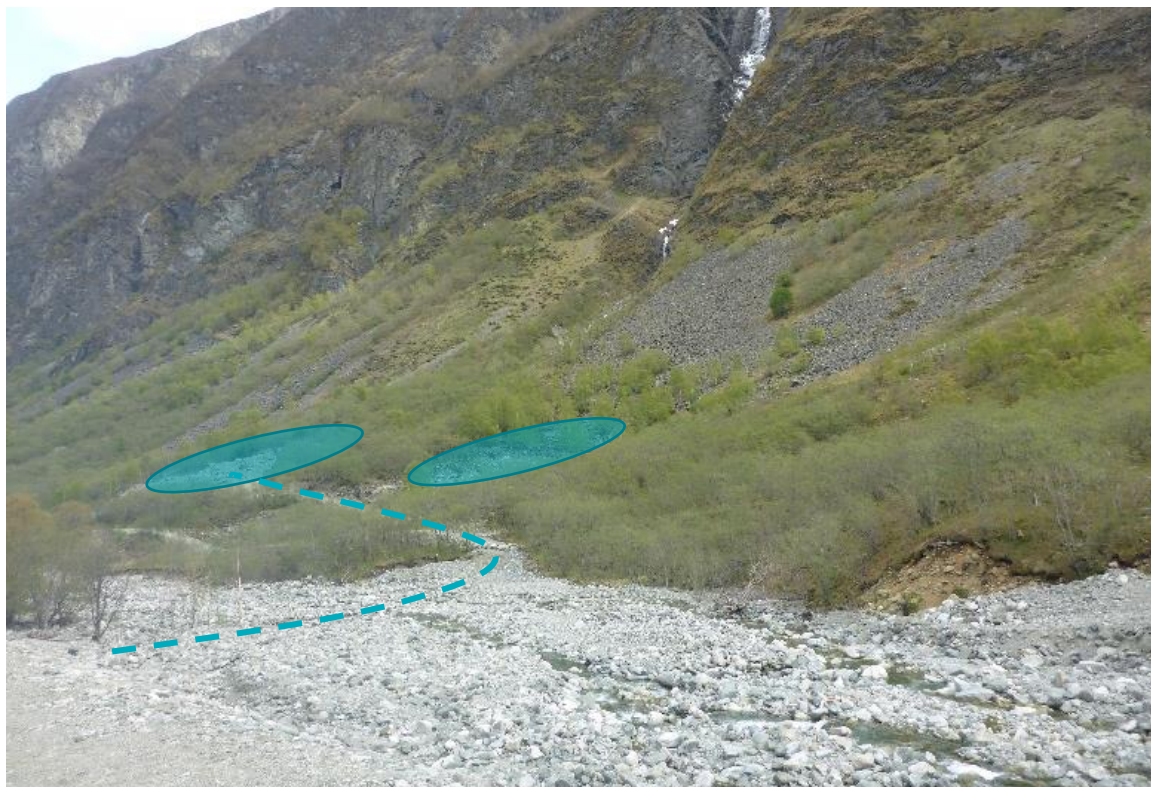
Figur 28 Tipper utformes som rasvifter i områdene som er benyttet til anleggsvirksom het tidligere. Midlertidig adgang til deponiene via eksisterende anleggsvei. Veien krysser Kuvelda og kan ikke benyttes i flomperioder.
