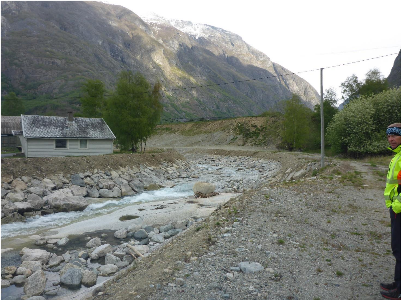
Figur 11 Midlertidig adkomst til Fosseteigen kraftstasjon langs eksisterende veg/elveforbygning langs høyre elvebredde.
