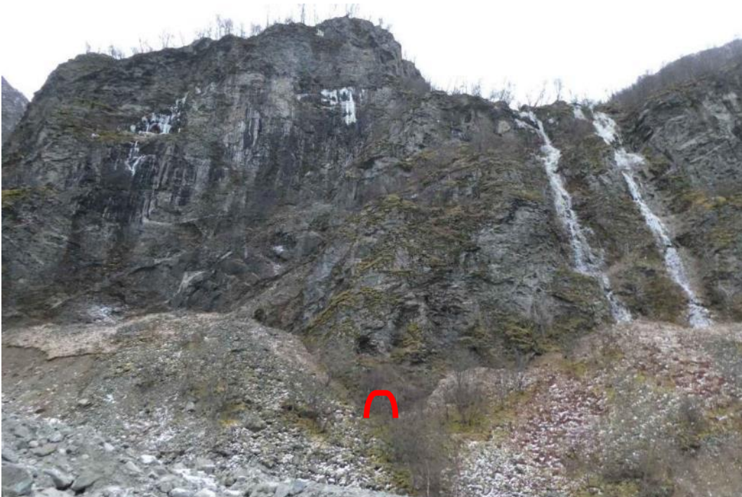
Figur 3 Tunnelpåhugg alternativ øst. Foten av berghammeren ligger på kote 435.
