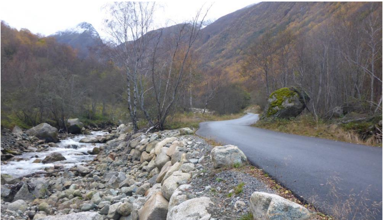
Figur 9 Kryssing av elv sett oppover dalen
