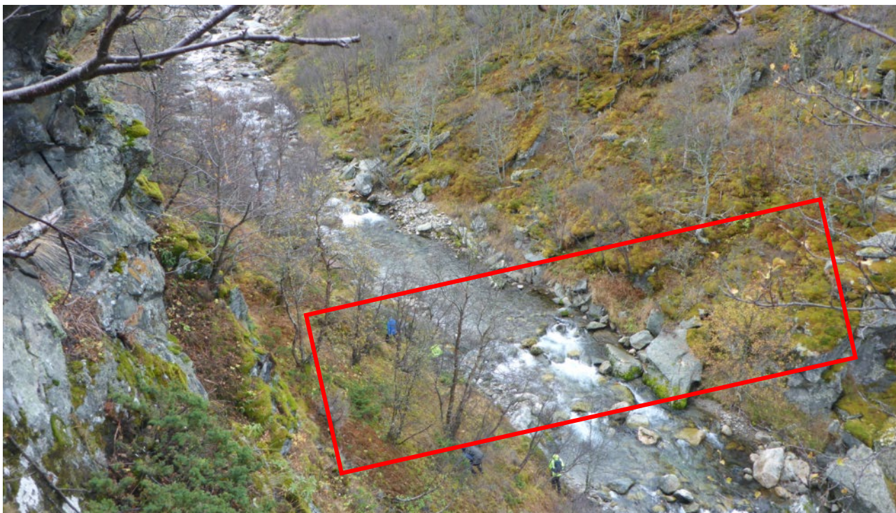
Figur 2-2: Foto over inntaksområde sett oppstrøms. Dam er planlagt plassert innenfor rødt område. Område for oppsamlingsbasseng og boregrop for sjakt ligg på høyre side av elva.
