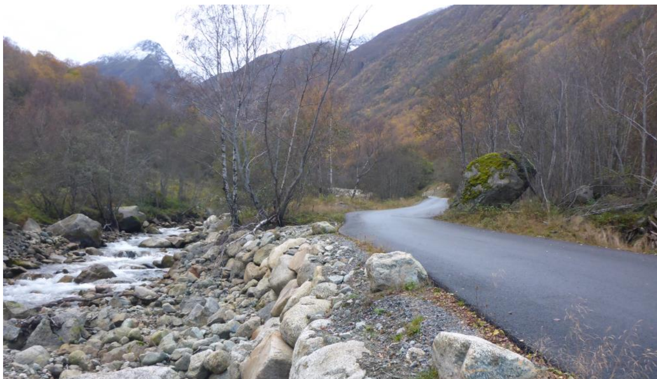
Figur 2-17 Kryssing av elv sett oppover dalen
