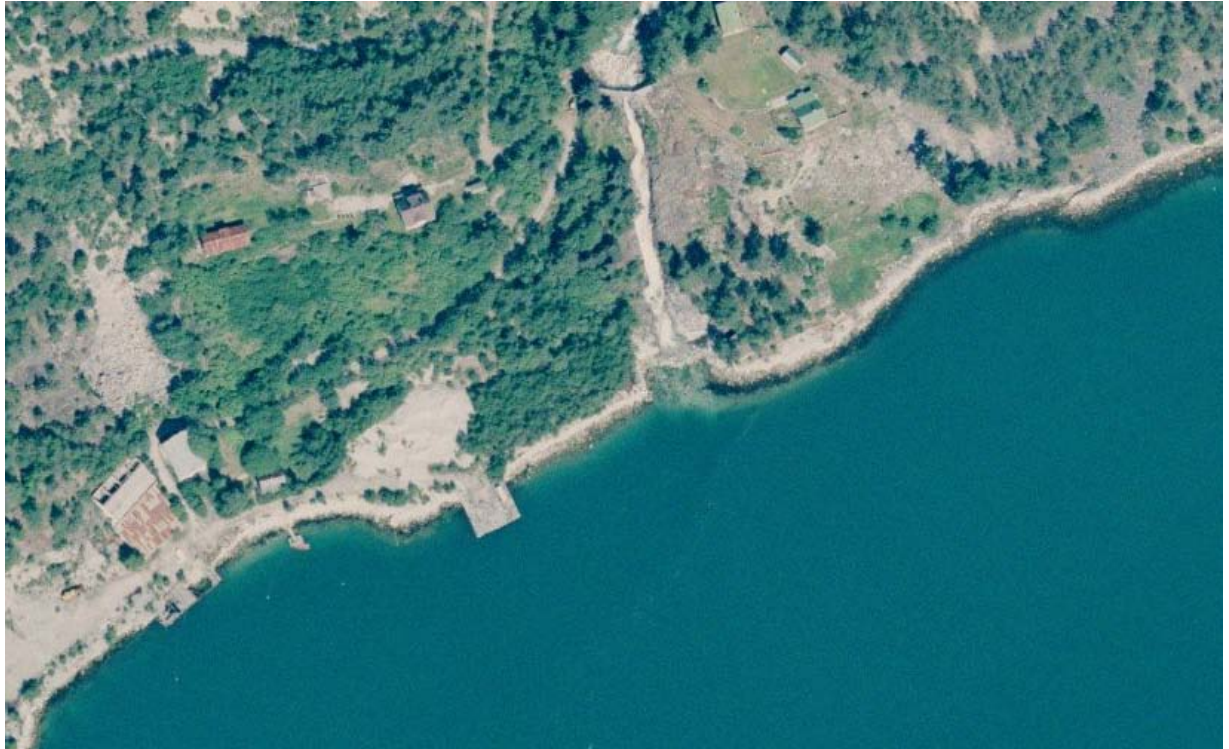
Figur 12. Flybilete av utløpet til Ytre Offerdalselvi.
