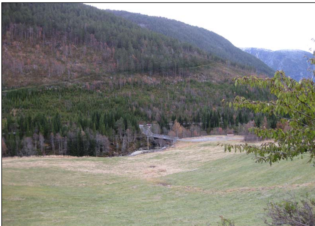
Figur 10. Området i østre dalside i Indre Offerdal, der det planlegges å deponeres stein fra tunneldrivingen fra Ytre Offerdal. Her sett fra området ved Skogli før deponering (Detaljplan miljø og landskap, Multiconsult).
