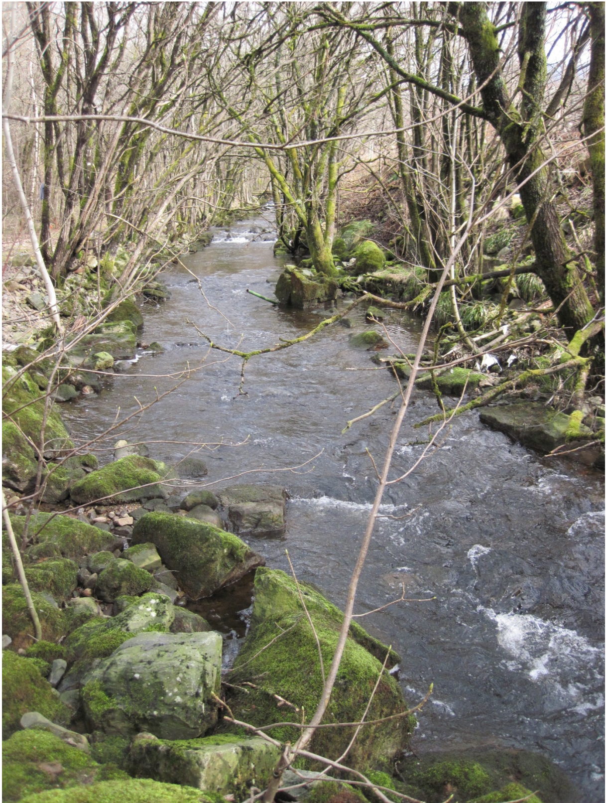
Fig. 14 Denne erosjonssikringen med uregelmessig steinutlegg («steinrøys») og trær i Sælenelven har tålt mange tår med flommer og har gitt langt bedre miljøforhold enn glatt plastring eller mur. Sedimentdynamikk er redusert, men det finnes fortsatt skjul, hulrom, røtter og trær langs elvekantene.
