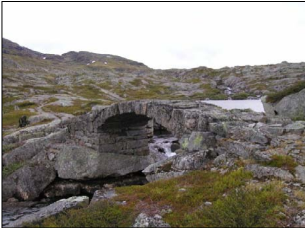
Gamal bru over Breiåni Foto: Trond Aalstad
