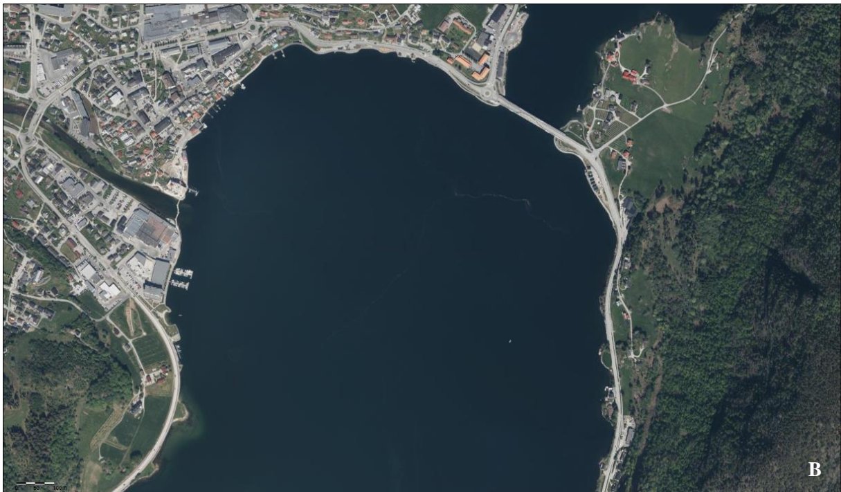
Figur 17. A: Bilde fra granskingsområdet ved Sogndal. B: Flyfoto av granskingsområdet hentet fra kartlaget "Kinn og Midtre Sogn 2021" på Norge i Bilder.
