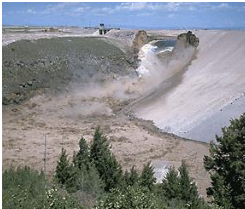
Dambrot i "The Teton dam" i Idaho, USA, 5. juni 1976, der 14 menneske døydde (Foto: U.S. Department of the Interior)
