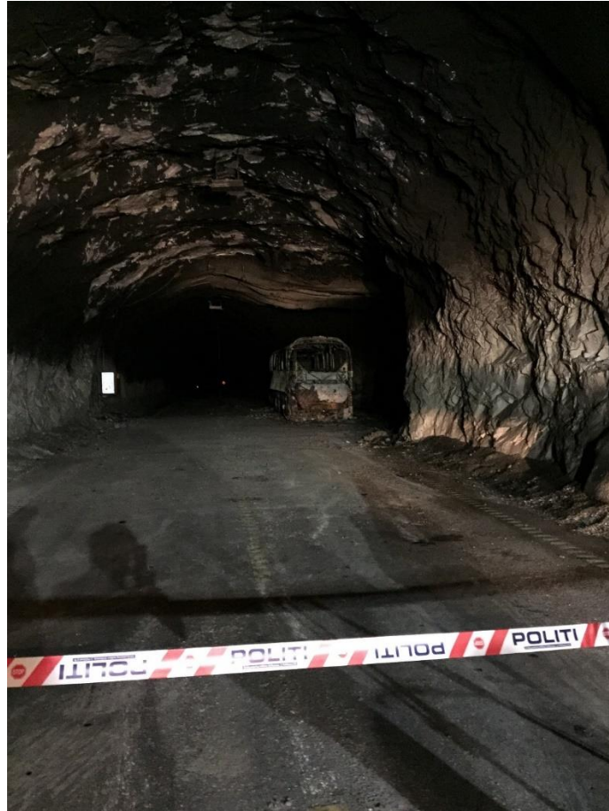
Den utbrente bussen i Gudvangatunnelen i august 2015
