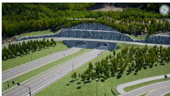
Figur 4-33. Portal Åsentunnelen nord. Lokalveg legges over tunnelåpene.
