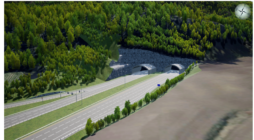
Figur 4-63. Grubbåstunnelen portaler nord.
