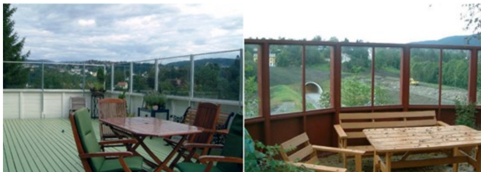
Figur 4-47. Eksempel på lokale støytiltak på uteplass for støyuutsatt bebyggelse. Figur er hentet fra SVV Håndbok 135 Fasadeisolering mot støy [22].
