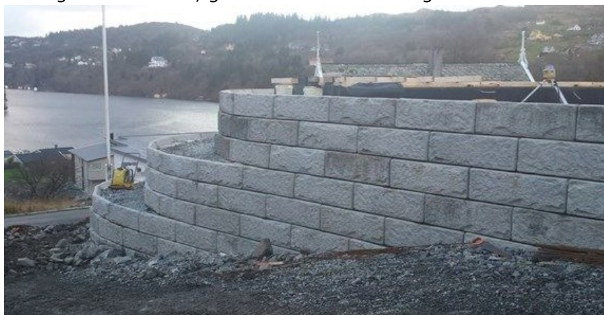
Figur 4-73. Støttemurer kan utføres som systemblokkmurer av betong med naturtro, granitt- eller kalksteinlignende fasade. Foto: www.skudestein.no .
