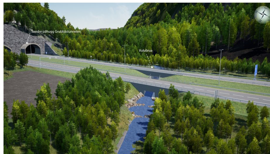
Figur 4-68. Illustrasjon viser Vulubrua der elva Vulua går under E6 i en kulvert av plasstøpt betong, sett mot øst.
