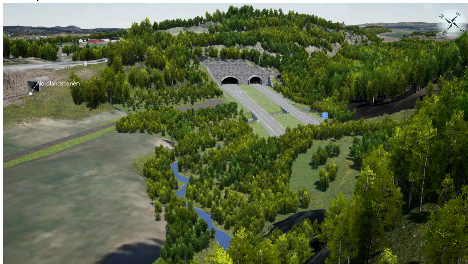
Figur 4-50. Revegetering sørger for at omlegging av elveløpet til Vulua beholdes som en grønn struktur, og bidrar på denne måten til å innlemme veganlegget i landskapet.
