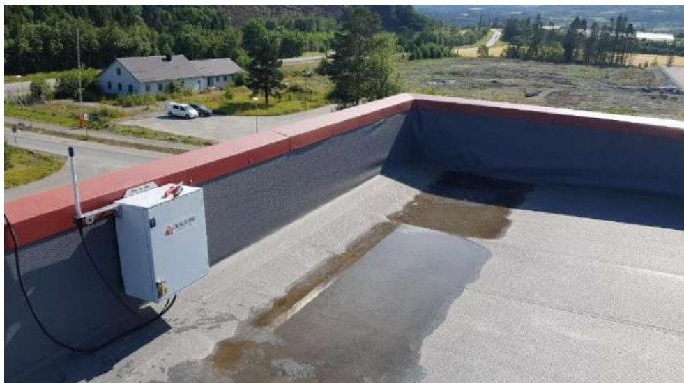
Figur 2-2: Bilde av installert Gateway, montert på taket til et næringsbygg ved Hofstadvegen 15.
