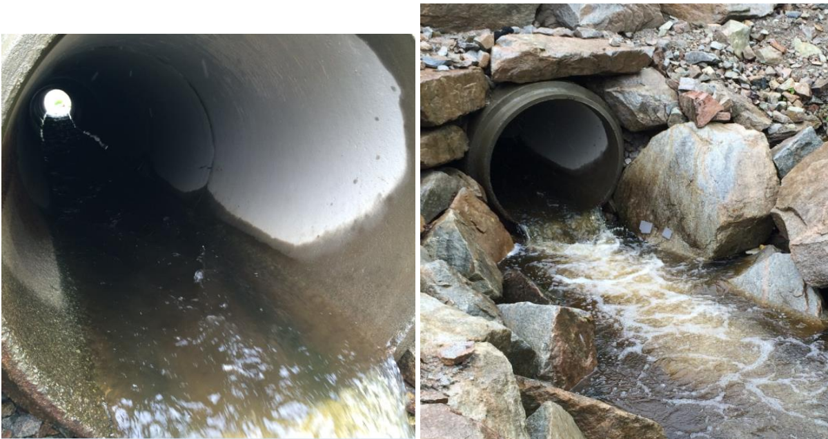
Fig 18. Nyetablert kulvert under vei inn til HAMOS sin miljøstasjon.
