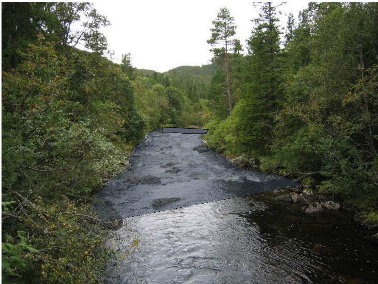
Bilde 1 – Planlagt inntak til Osaelva kraftverk sett ovenfra og fra brua
