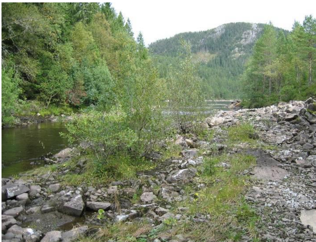
Gammel fylling i utløpet fra Ytre Osavatn
