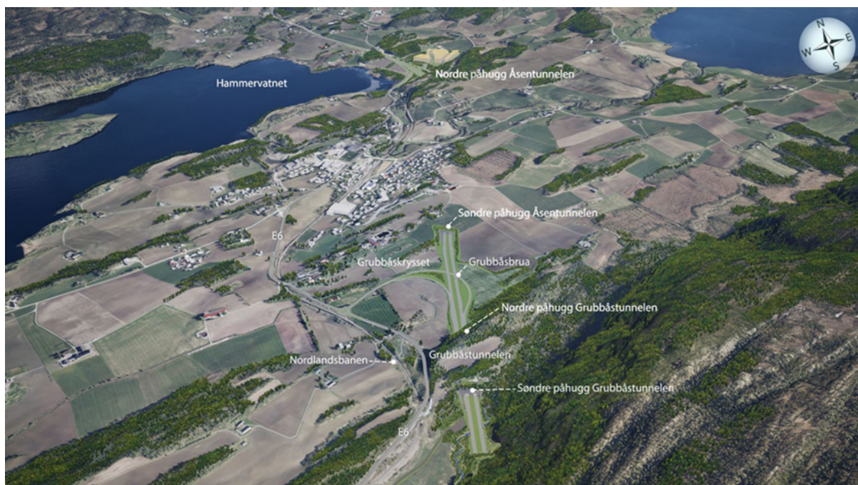
Figur 44: Oversiktsbilde over Åsen-området. Fra sør mot nord går vegen gjennom dagsone Kleiva, Grubbåstunnelen, dagsone Stokkan, Åsentunnelen og dagsone Vassmarka.
