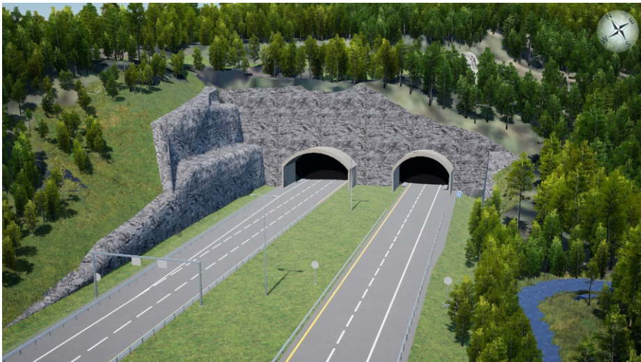
Figur 50: Grubbåstunnelen, portaler sør.
